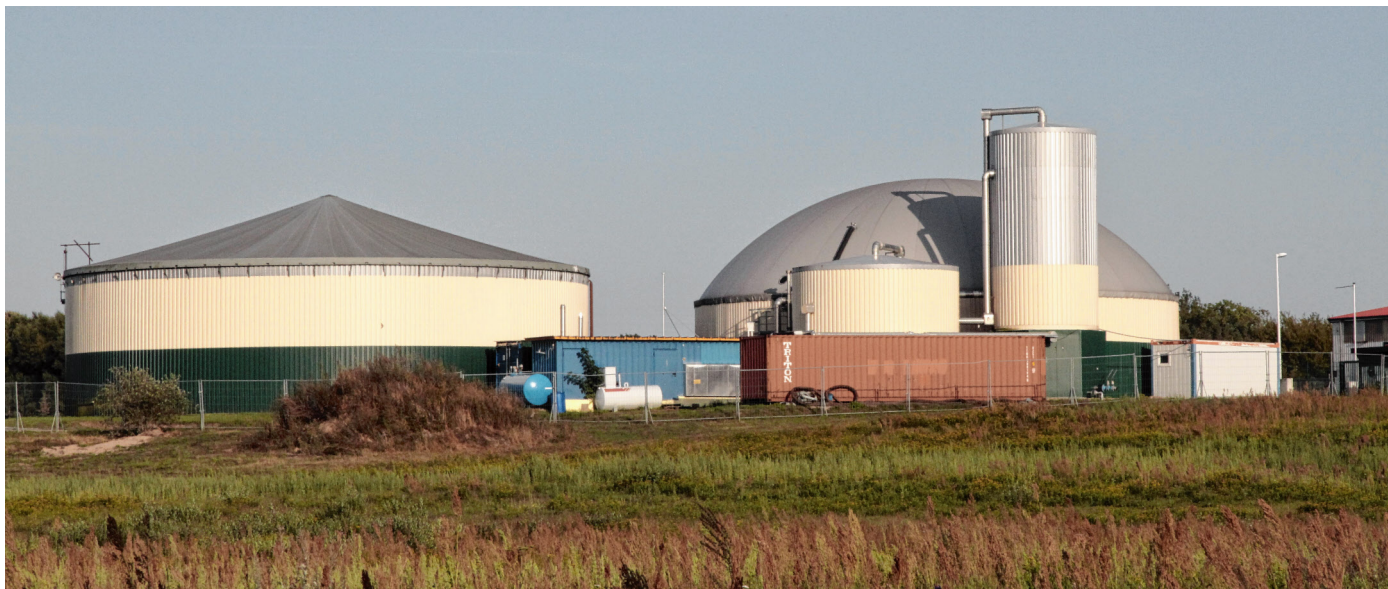
Stillgelegt seit Mai 2018: die Biogasanlage im Lalendorfer Gewerbegebiet.
